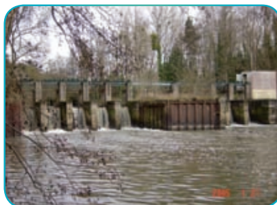
Barrage de Rouillon, 1 er obstacle à la circulation des poissons depuis la Loire
